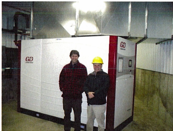
New 135 hp VSD air compressor
