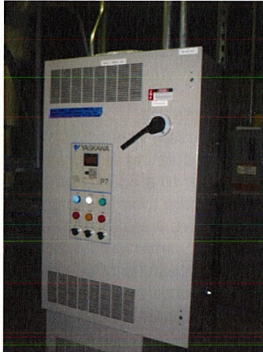
50 hp Supply Air Fan VFD
